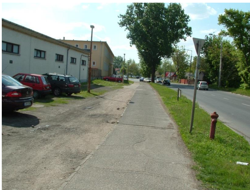
37. ábra: Kerékpárút a Szolnoki úton
